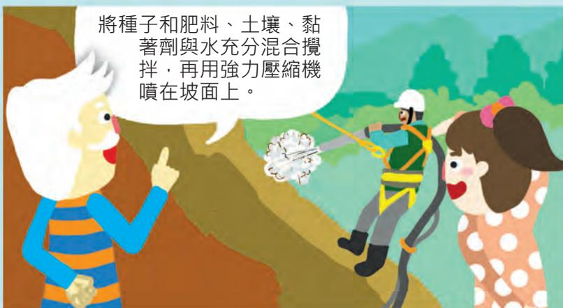
將種子和肥料、土壤、黏著劑與水充分混合攪拌，再用強力壓縮機噴在坡面上。
